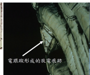
放電痕跡橫跨繞組支架(清潔繞組端部後所見)
