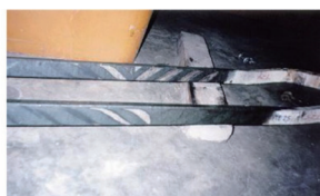
由於繞組端部振動，導致棒條磨損(產生槽放電)
