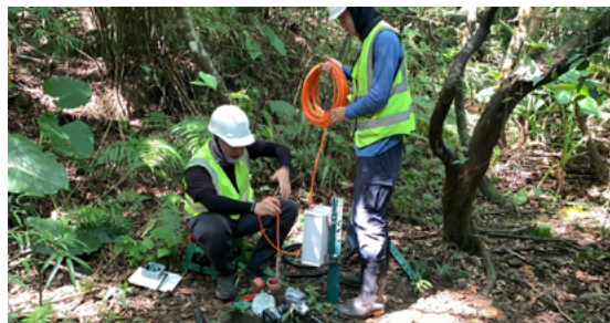
圖 10. 邊坡水壓計及 VWdot 儀器安裝照片 (陸島工程顧問 (股) 公司提供照片)
