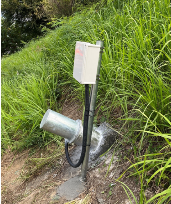
圖 12. 邊坡地錨荷重計及 WBdot 儀器安裝照片 (陸島工程顧問(股)公司提供照片)
