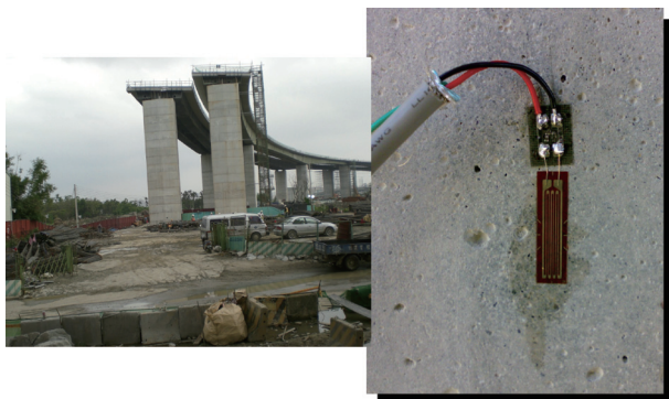
▲ 圖23 混凝土應力檢測
