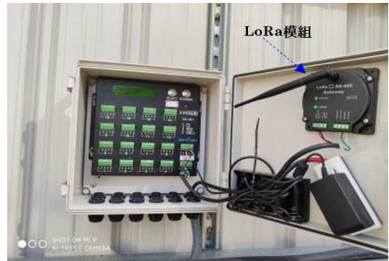
圖 10. 結合 LoRa 模組振弦感測器掃描箱
