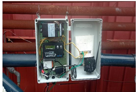
圖 11. 透過 LoRa 將資料傳回記錄器端
