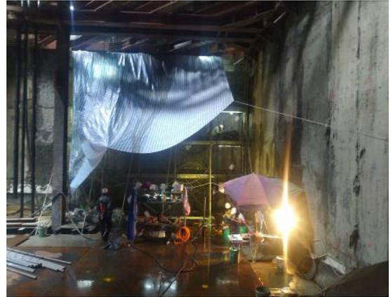
圖 25. 鏡面二次灌漿作業
