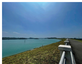
圖 4-c. 溢洪道上游方向
