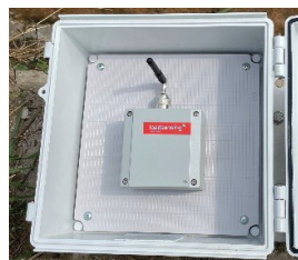
圖 8-c. LoRa 傾斜計安裝照片
