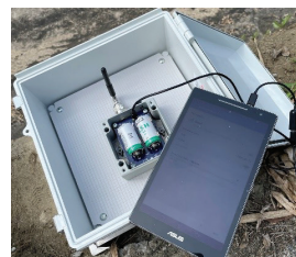
圖 8-d. LoRa 傾斜計安裝照片
