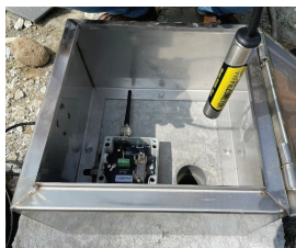
圖 8-a. 電子式水壓計安裝照片
