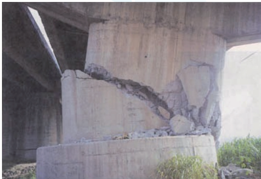
此為橋墩受到過大剪力而破壞的案列
