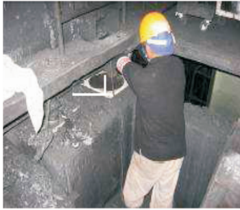
▲用錨定螺栓固定底板
