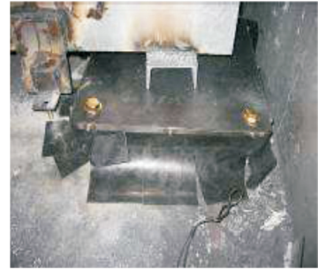
▲隔震裝置設置後裝上防塵蓋
