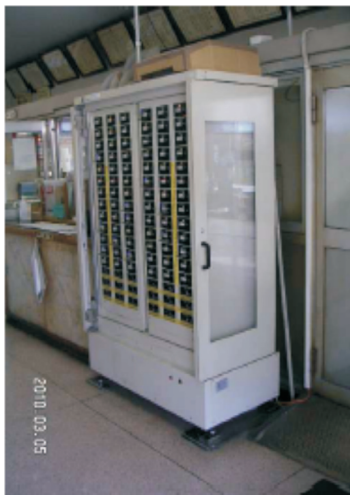
▲承載物施工前
