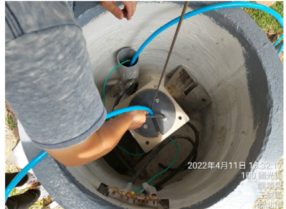
圖 5. 井口端作業完畢收納纜線與鋼索，將剩餘的纜線收納入井體。中間部分封井單元由上至下依序有應力釋放裝置、金屬盤以及橡皮塞，收納完畢及蓋上井蓋。
