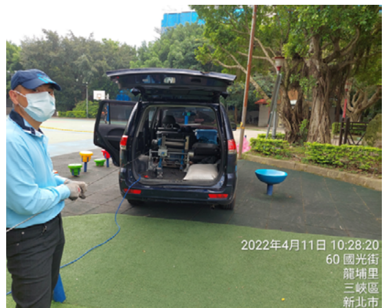
圖 6. 三峽站捲揚機端作業圖。此圖正在將鋼纜預先捲上車體內的電動捲揚機。
