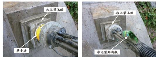
▲ 圖4 可重複補漿數次之水泥漿点滴瓶和水泥漿滿溢目視檢測方式
