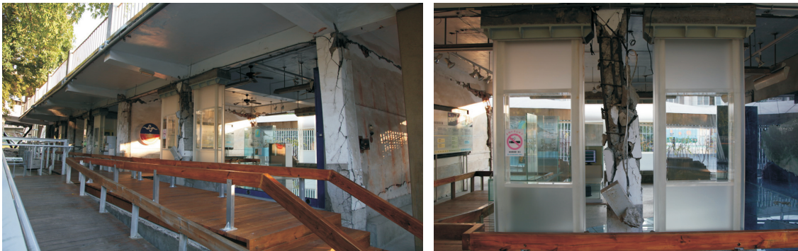
▲ 圖1 九二一地震教育園區毀損南棟教室與壓克力補強現況
