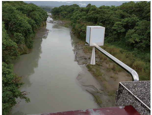
▲ 圖2 雷達波水位計裝設於仁義潭大橋位置
