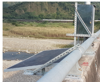
▲ 圖6 太陽能板及開關箱橋上安裝施工後
