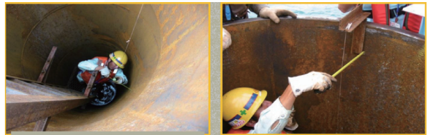
▲ 圖3 基礎垂直度量測檢驗(海事工程實務,廖銘洋)
