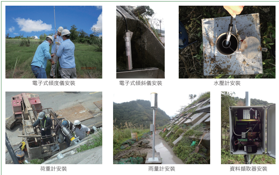
▲ 圖2 邊坡自動化監測儀器安裝
