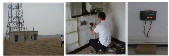
圖 6. 安裝現場情況 (張家口移動基站)
