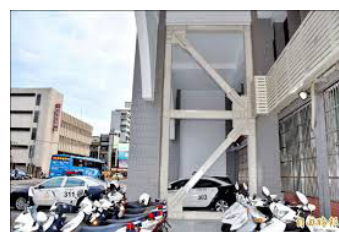
圖 2. 耐震結構補強實例二
