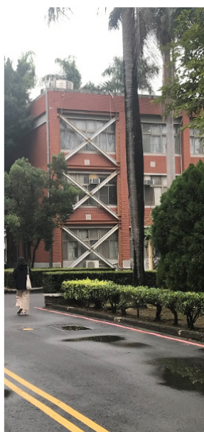
圖 1. 耐震結構補強實例一
