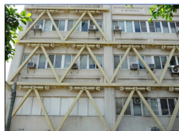
圖 3. 耐震結構補強實例三
