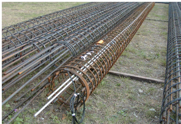
▲ 圖7 樁體變位計安裝
