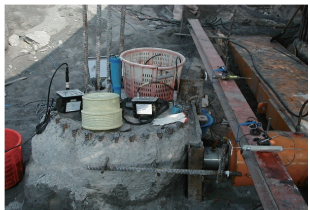
▲ 圖11 傾斜管量測
