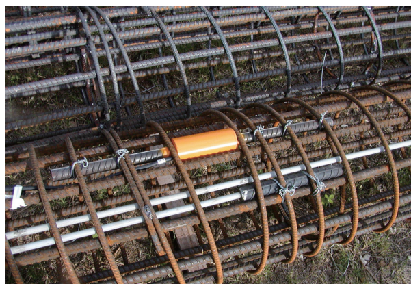
▲ 圖8 樁體變位計錨碇端
