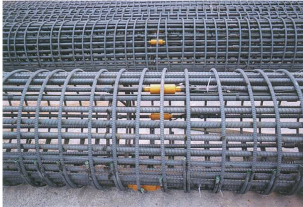
▲ 圖6 鋼筋應力計安裝
