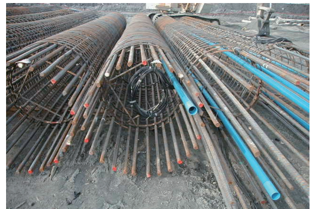
▲ 圖10 傾斜管安裝
