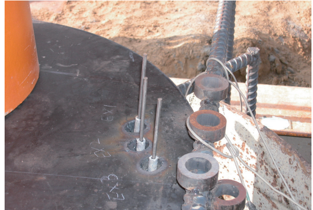
▲ 圖9 樁體變位計量測端
