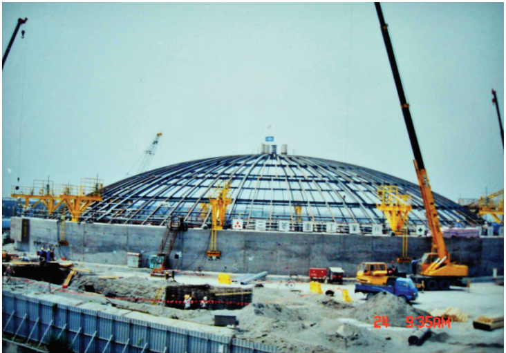
LNG 貯槽工程施工情形 (3)
