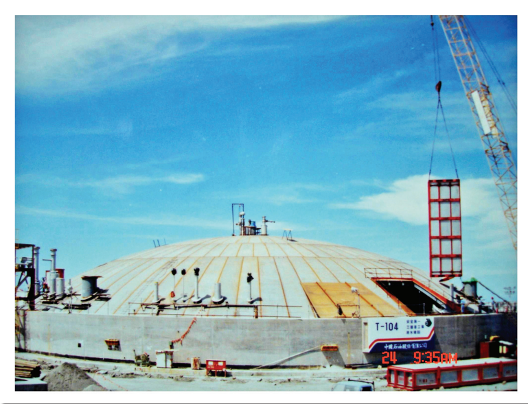
LNG 貯槽工程施工情形 (5)
