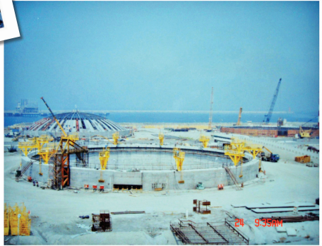
LNG 貯槽工程施工情形 (2)
